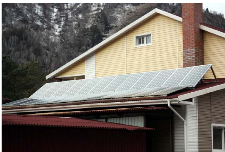
Рис. 4. Размещение солнечных модулей на крыше котельной
