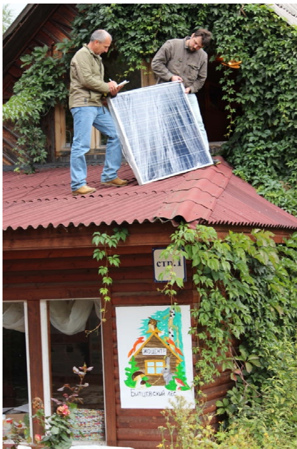
Рис. 1. Монтаж оборудования для образовательного проекта «Свет и просвещение»
