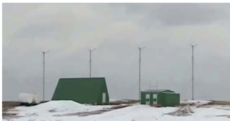
Рис. 6. Ветро-солнечно-дизельная станция в деревне Пялица Терского района Мурманской области.
