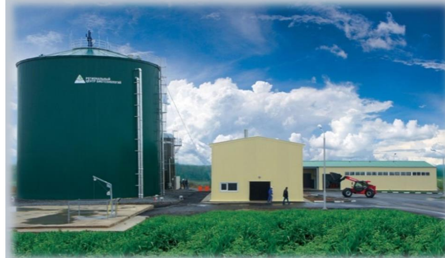
Биогазовая станция «Байцуры» Белгородская обл.
