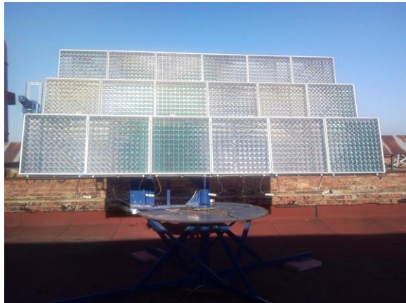
Фотоэнергоустановка на трекере башенного типа (1кВт)
