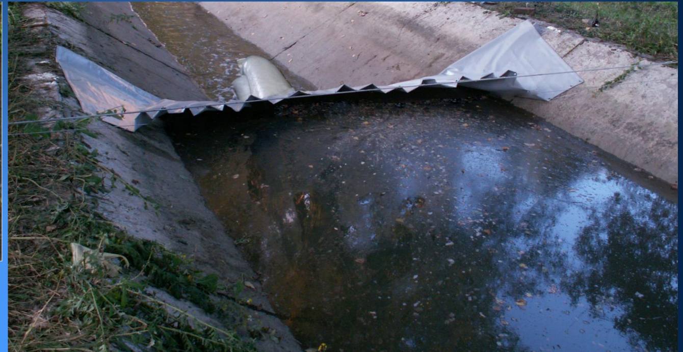
Вид со стороны верхнего бьефа
