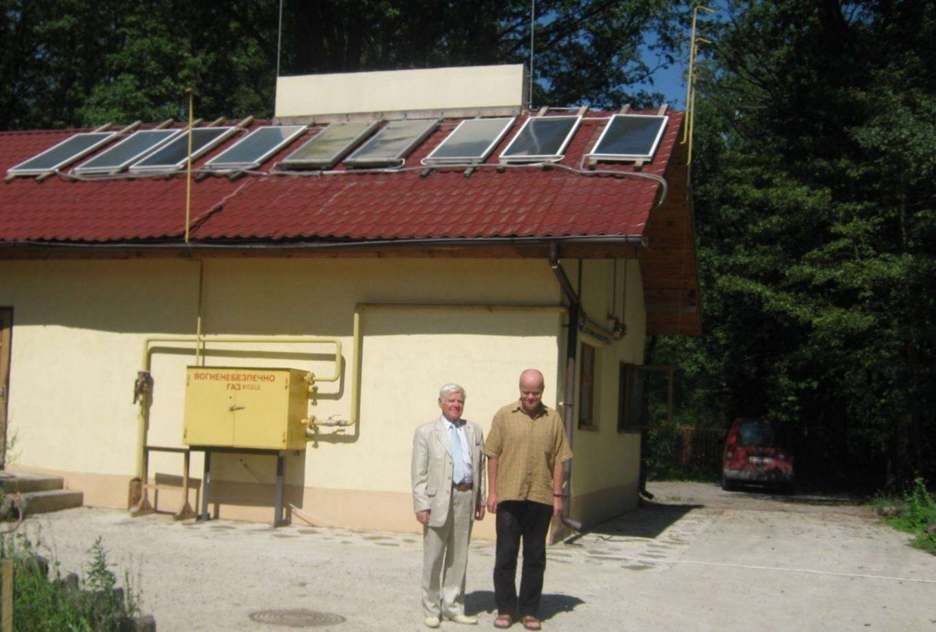
Солнечная котельная в детском доме
