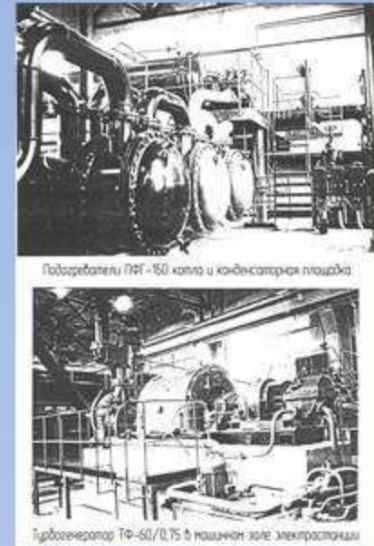
Турбогенератор ТФ-60/0,75 в машинном зале электростанции
